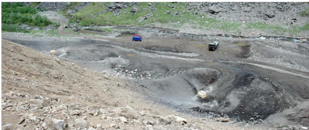
Figur 1.2 Demoleringsgropene på destruksjonsanlegget i Øyradalen.
